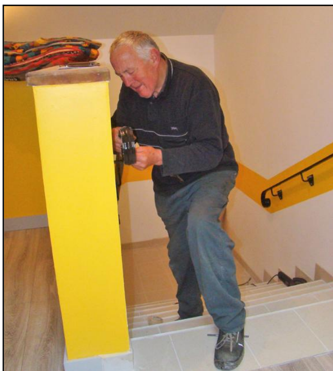
Gérard Burr, lors de la pose des mains-courantes de l'escalier
